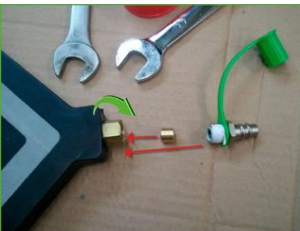
Рис. 6.3 Замена штуцера подъемной подушки
